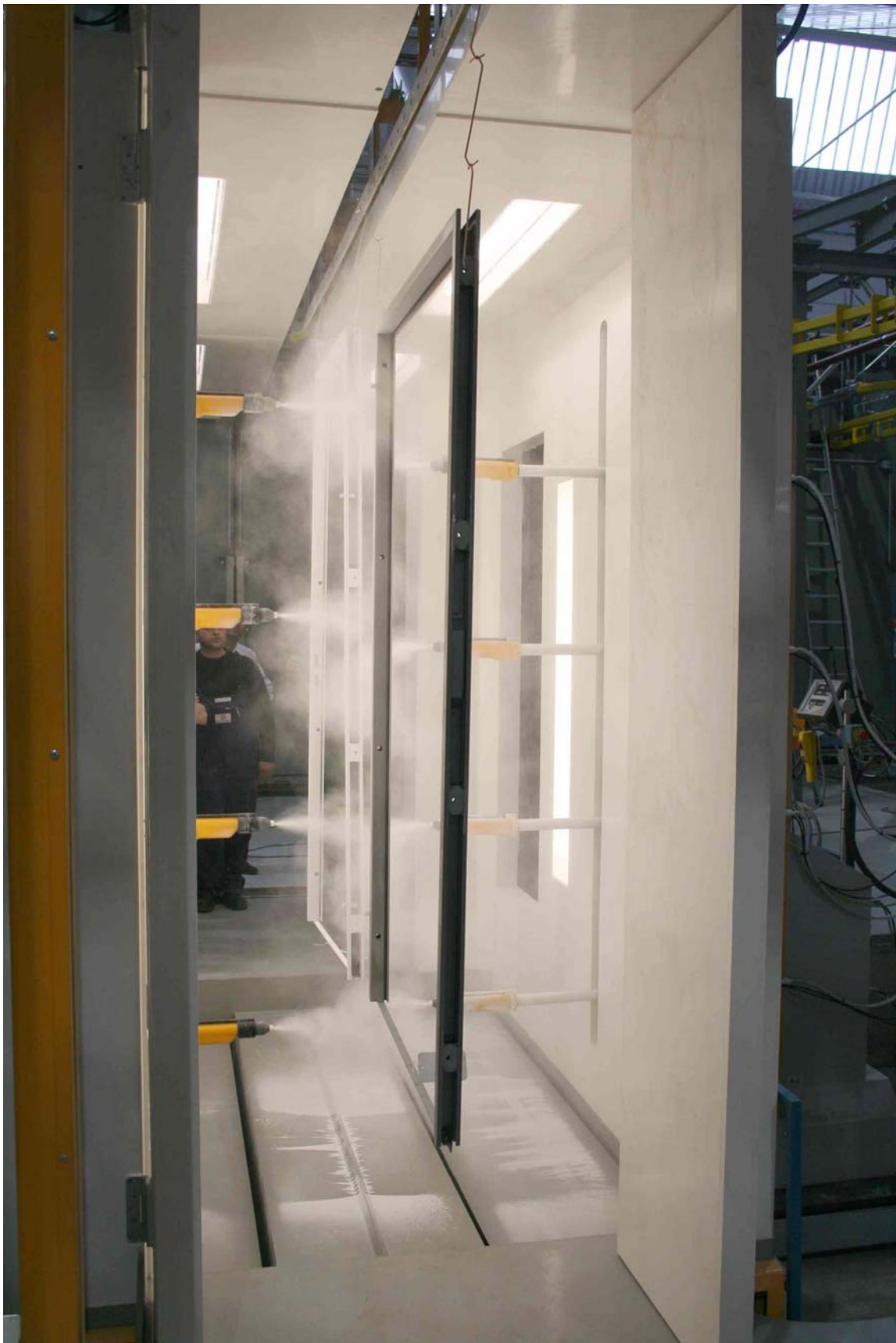
Pulverbeschichtungskabine mit Stahlzarge, die beschichtet wird.
